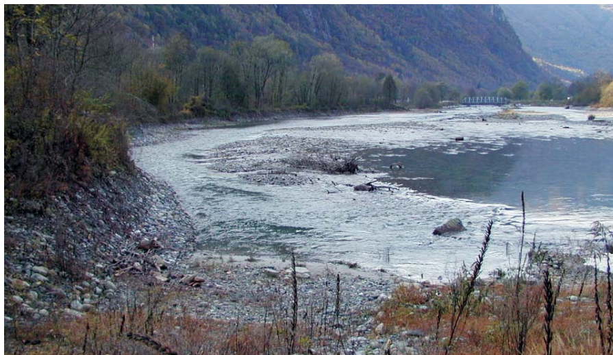
Dank einer Flussaufweitung konnte ein seit gut hundert Jahren vom Talfluss Moesa abgeriegeltes Auengebiet bei Grono revitalisiert werden.
