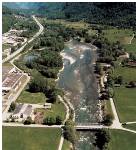
Aufweitung des Moesa-Gerinnes bei Pascoletto in Grono, 2000
