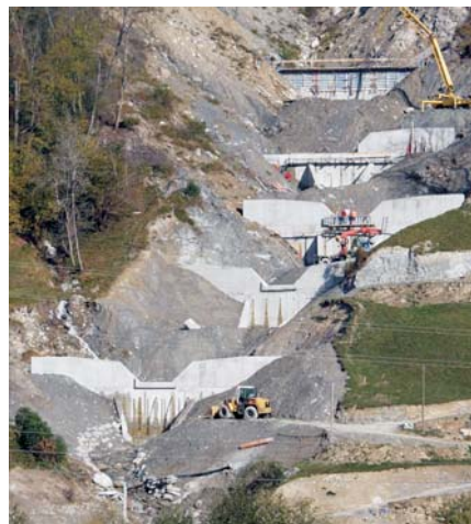
Sperrenbau im Val Fabertg bei Schlans zum Schutz der RhB, 2004
