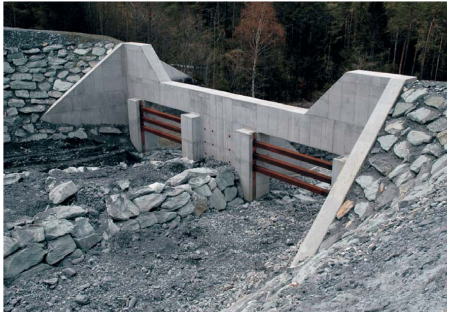
Das Auslaufbauwerk mit den beiden je 35 Quadratmeter grossen Öffnungen
